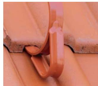
Um die Funktion bzw. die Regensicherheit eines Daches nicht zu beeinträchtigen, sind gegebenenfalls Anpassungen am Bedachungsmaterial (zB Entfernen des Kopf- oder Fußfalzes) vorzunehmen.
